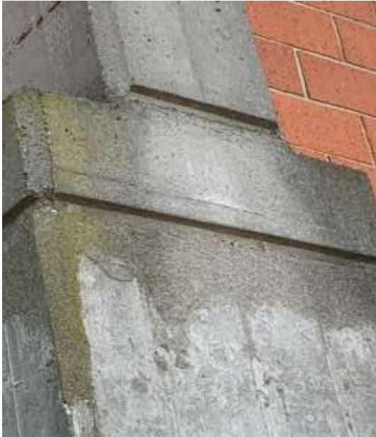
Εικόνα 6: Υγρασία λόγω καιρικών συνθηκών
