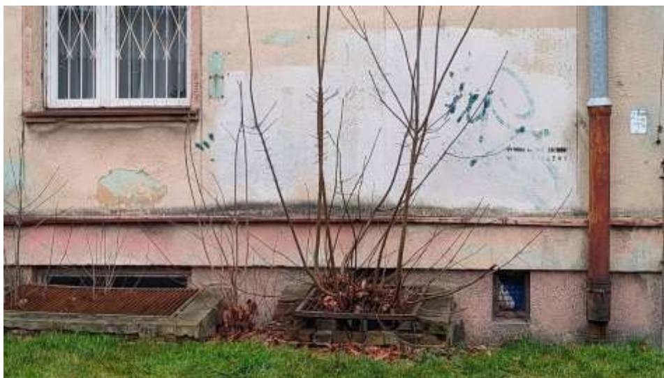
Εικόνα 13. Αυτοφυή δέντρα και θάμνοι που καταστρέφουν τις δομές των υπογείων παραθύρων από τούβλα
