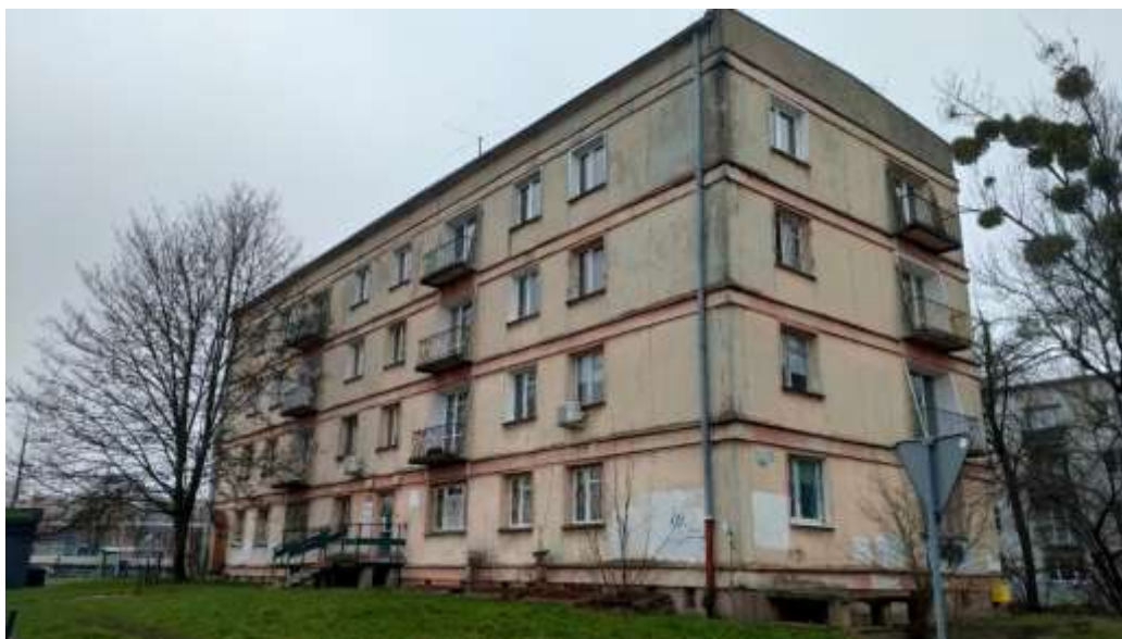
Εικόνα 1. Κτίριο στο Lodz για οικιστική χρήση, με δημόσιο ίδρυμα υγείας στο ισόγειο.
