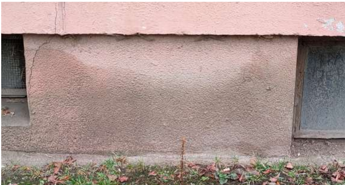
Εικόνα 7. Ο τοίχος θεμελίωσης από σκυρόδεμα παρουσιάζει ορατά σημάδια αυξημένης παρουσίας υγρασίας
