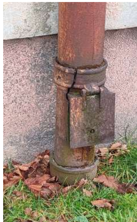
Εικόνες 10-11. Βλάβη σε σωλήνα αποστράγγισης λόγω παγετού ή μηχανικής δύναμης, με αποτέλεσμα την αυξημένη διείσδυση του νερού στους τοίχους των θεμελίων και με τη σειρά της - αυξημένη υγρασία.
