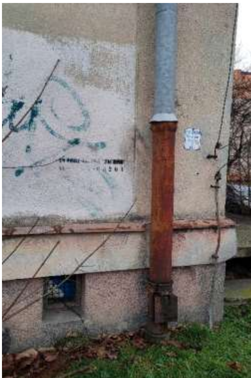
Εικόνες 10-11. Βλάβη σε σωλήνα αποστράγγισης λόγω παγετού ή μηχανικής δύναμης, με αποτέλεσμα την αυξημένη διείσδυση του νερού στους τοίχους των θεμελίων και με τη σειρά της - αυξημένη υγρασία.
