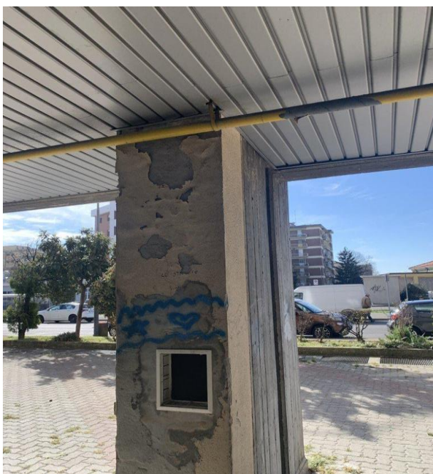
Pilt 2: Tehnoloogilise õõnsuse majutuse müüritise näitamine müüritise lagunemine seisukord
